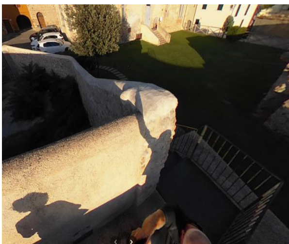
16 Via C. Battisti. Scala per accedere al camminamento della cinta muraria
