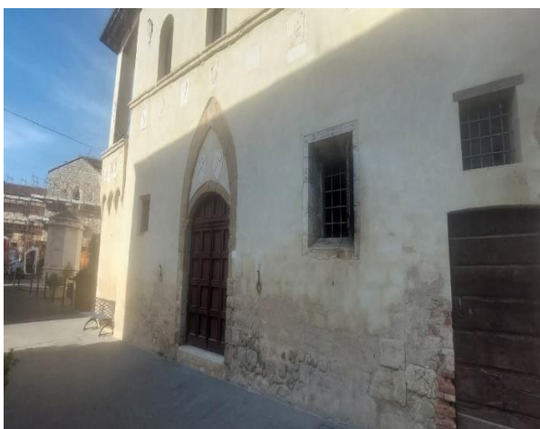
28 Palazzo dei priori. Portale di ingresso con arco acuto
