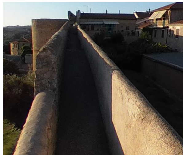
17 Camminamento cinta muraria
