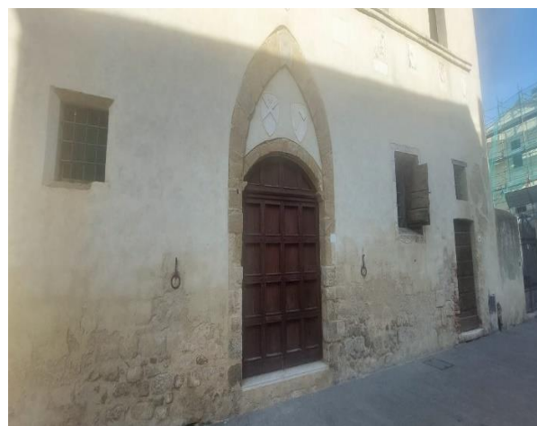
29 Gradino Portale di ingresso
